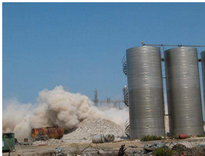
Demolizione con esplosivo
