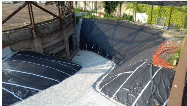
Demolizione parziale di un Gasometro per riqualificazione
