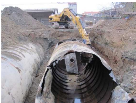
➡ Ex Deposito carburanti. Riduzione volumetrica in situ dei serbatoi
