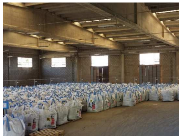
Decommissioning impianti ossiclorurazione, starlene e celle cloro al mercurio
