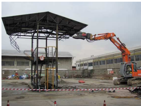
➡ Ex Deposito carburanti. Demolizione pensilina di carico
