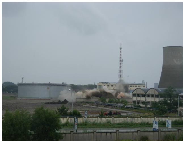
Demolizione di camini
