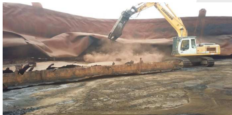
Decommissioning serbatoio «TK513» da 100.000 mc
