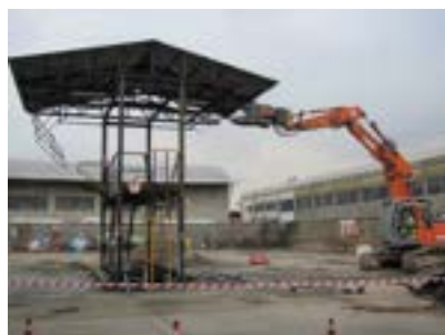
Ex Deposito carburanti. Demolizione pensilina di carico
