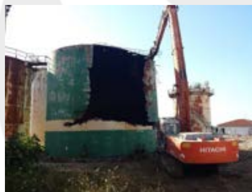
Deposito con serbatoi di grandi dimensioni: fasi di demolizione strutture fuori terra
