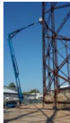
Demolizione parziale di un Gasometro per riqualificazione
