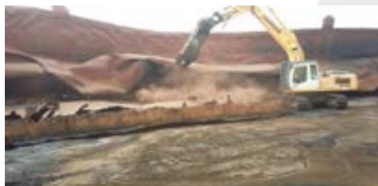
Decommissioning serbatoio «TK513» da 100.000 mc
